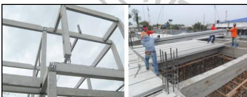
(ก) เสาและคานคอนกรีตสำเร็จรูป (ข) แผ่นพื้นคอนกรีตสำเร็จรูป
