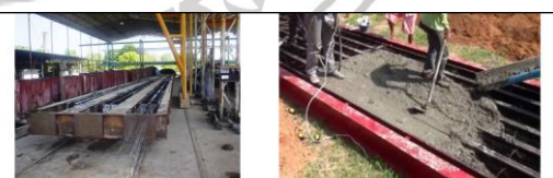
(ก) วางเหล็กและตั้งเหล็ก
