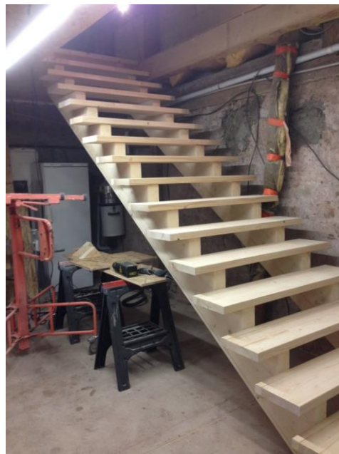
ข. แม่บันไดอยู่ใต้ขั้นบันได แบบแม่บันได 1 ตัว
