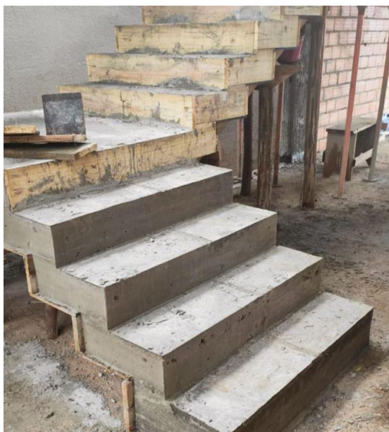
รูปที่ 6.43 ภาพแสดงลักษณะบันไดที่ทำการถอดแบบเรียบร้อยแล้ว
