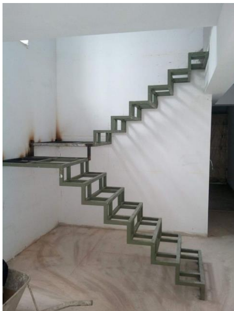
ก. โครงสร้างเหล็กแบบบันไดพับผ้า
