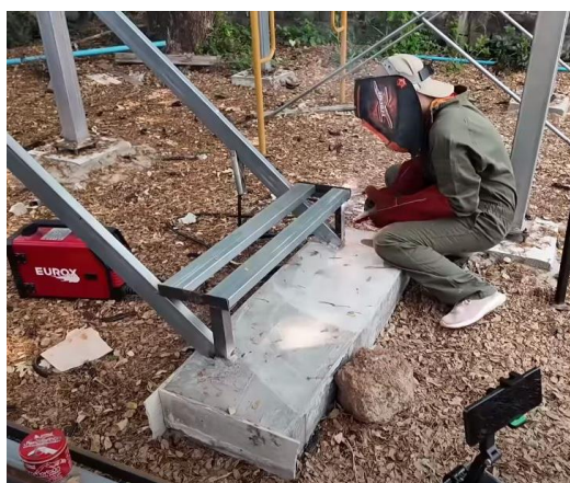
ก. การติดตั้งลูกนอนบันไดกับทุกบันได
