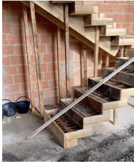
รูปที่ 6.41 ภาพแสดงลักษณะการตั้งไม้แบบลูกตั้งและลูกนอนบันได ที่มา : https://www.pinterest.com/pin/710935491186901336
