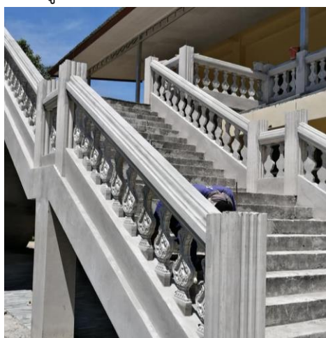
รูปที่ 6.24 ภาพแสดงลักษณะของราวลูกกรงคอนกรีต ที่มา : https://www.th-tile.com
