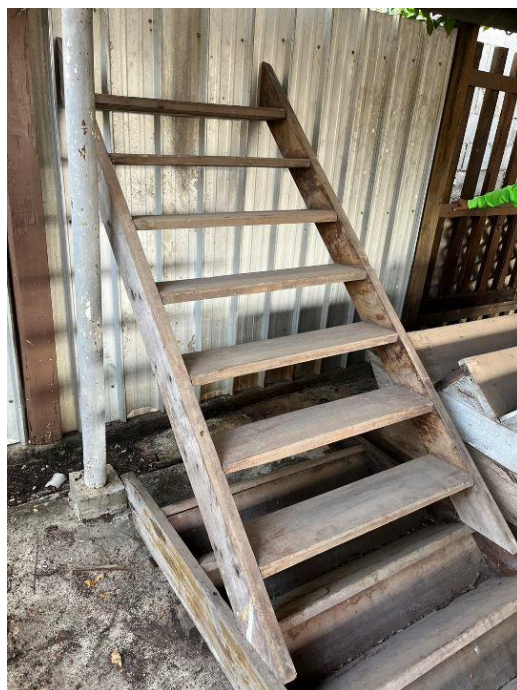
ก. แม่บันไดขนานข้างชั้นบันไดแบบโปร่ง
