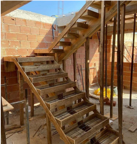
ก. โครงสร้างบ้านไคคอนกรีตเสริมเหล็กแบบมีแม่บ้านไค
