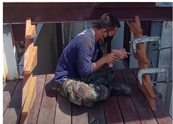
ข. ยึดพุกบันไดติดกับแม่บันได
