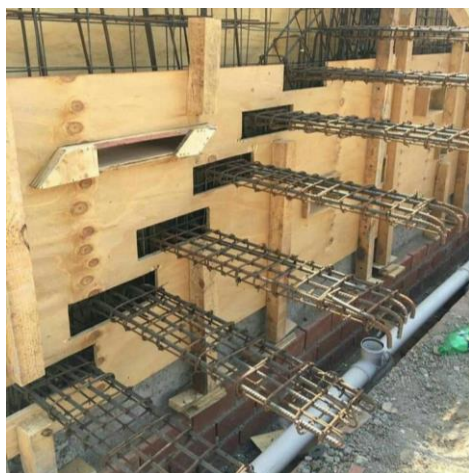
ก. โครงสร้างบันไดคอนกรีตเสริมเหล็กแบบบันไดลอย
