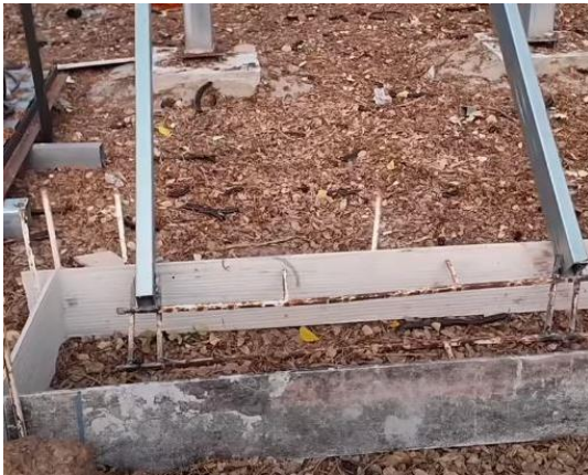
ก. การติดตั้งฐานรองรับบันไดด้วยฐานคอนกรีต
