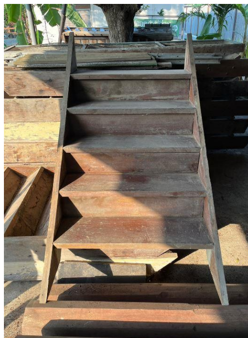
ข. แม่บันไดขนานข้างชั้นบันไดแบบทึบ
