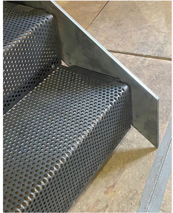
ข. แม่บันไดขนาดข้างชั้นบันไดแบบทึบ
