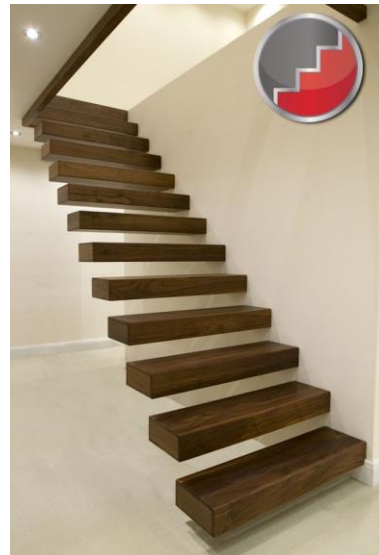
ข. บันไดเหล็กแบบบันไดลอย
