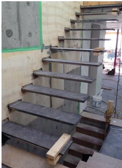
ก. โครงสร้างเหล็กแบบบันไดลอย
